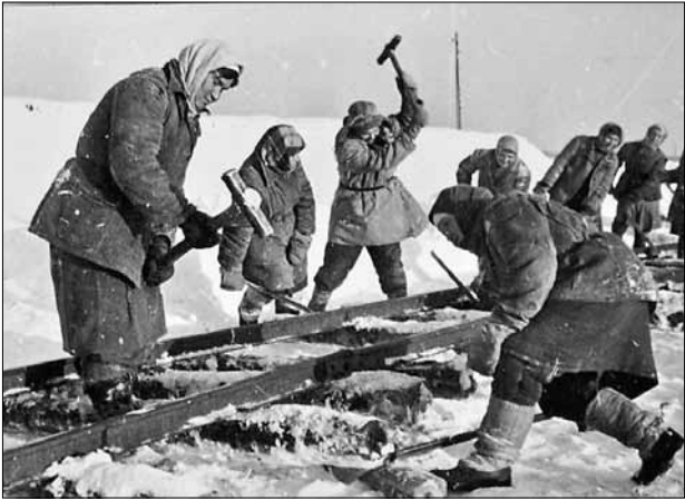
■ Строительство железной дороги Экономика – Исакогорка
