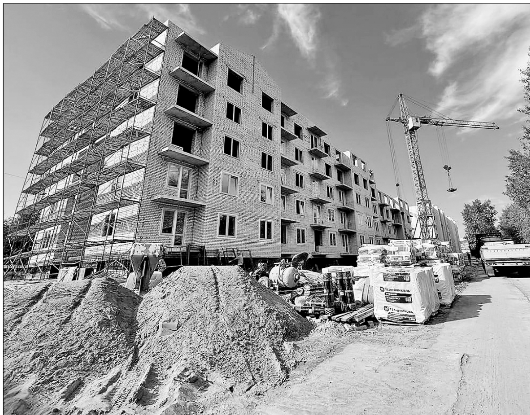
■ На улице Добровольского, 7 возводится дом общей площадью порядка трех тысяч квадратных метров
