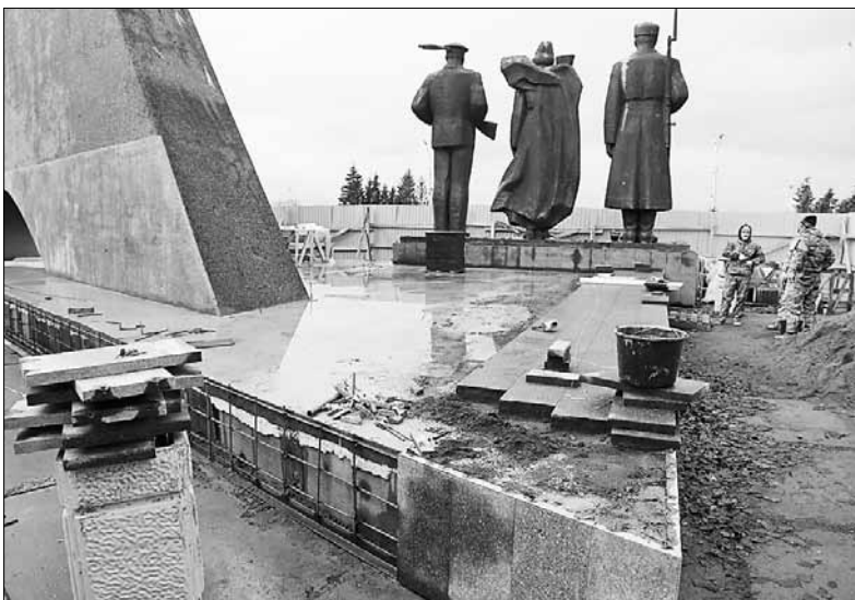
■ На площади Мира подрядчик укрепит ослабевший фундамент и облицует постамент карельским гранитом
