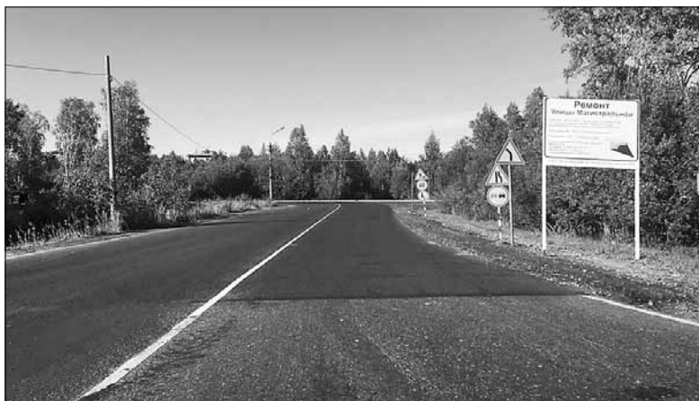
■ Ремонт улицы Магистральной
