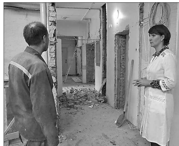
■ Главврач Юлия Моногарова постоянно контролирует ход работ. ФОТО: НАТАЛЬЯ СЕНЧУКОВА
