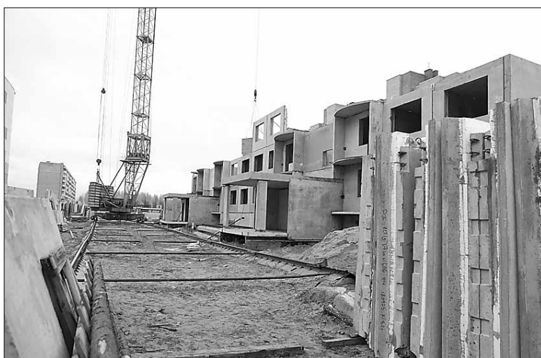
■ На Московском проспекте возводится социальный дом
