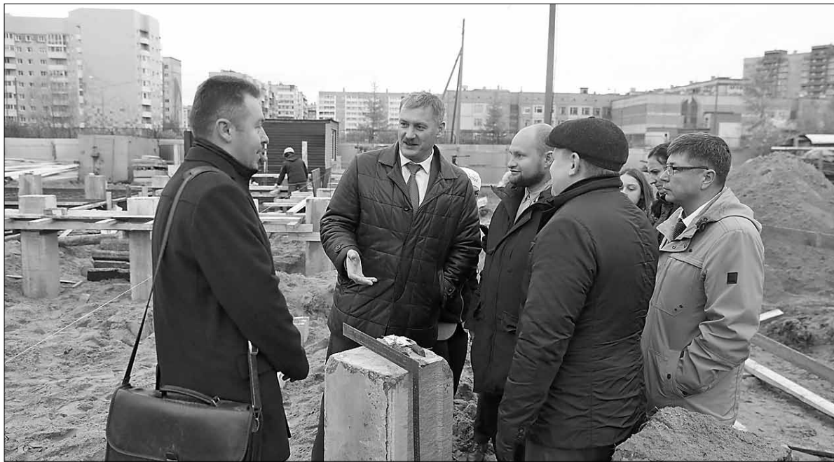
■ На строительной площадке будущего детского сада в 6-м микрорайоне глава города оценил ход работ
