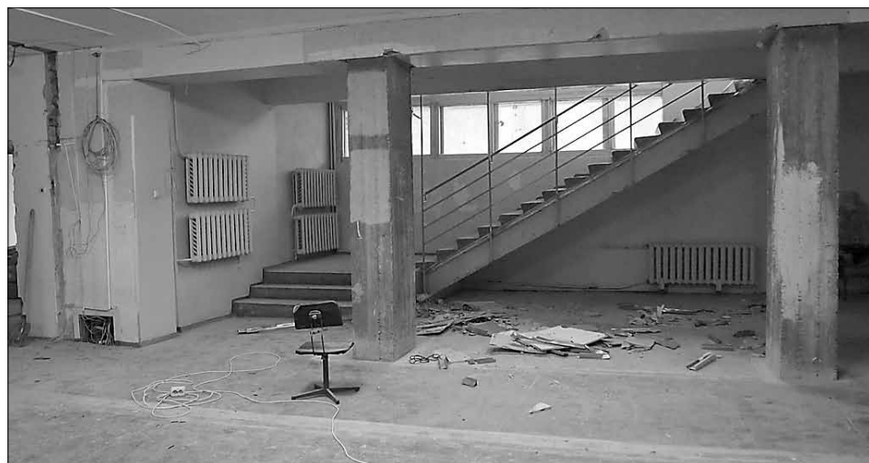
■ В пятиэтажном корпусе 7-й горбольницы на прошлой неделе начался ремонт помещений для новой регистратуры. ФОТО: НАТАЛЬЯ СЕНЧУКОВА
