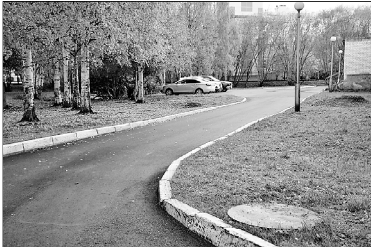
На территории ковидного госпиталя Архангельской областной клинической больницы выполнен ремонт дорожного покрытия
