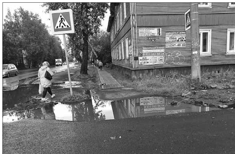
■ Тротуар на улице Мещерского до ремонта
