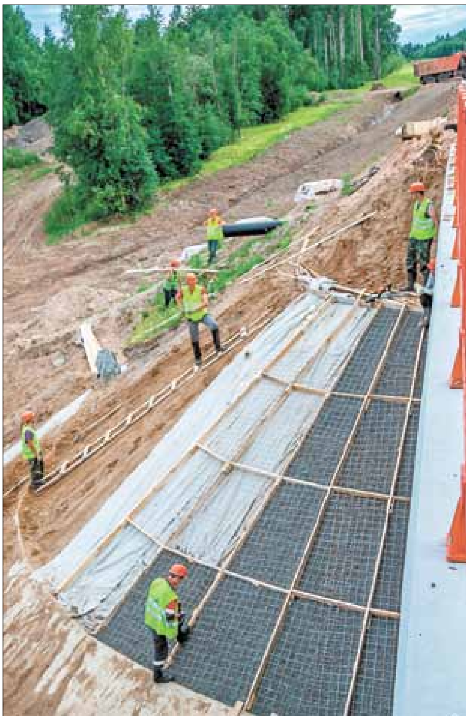
■ Отряд «Борей» с начала июля участвует в укреплении моста через реку Обокша
