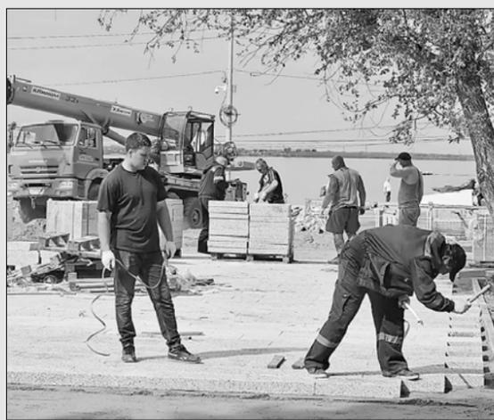
**Площадь у Вечного огня одевается в красивые бело-серебристые плиты из гранита. Рабочие выровняли поверхностный слой, для этого завезли несколько КамАЗов песка, сделали разметку. Часть дорожек уже вымощена новым покрытием.**
