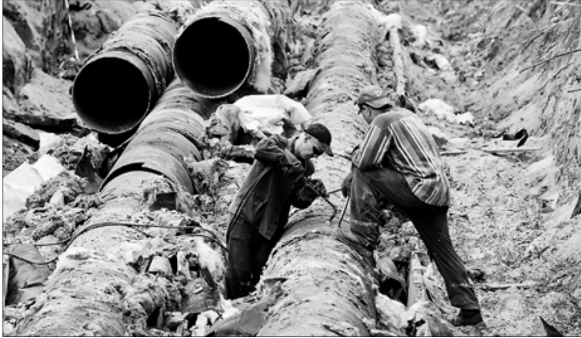
■ Своевременный ремонт теплосетей – залог успешного прохождения отопительного сезона. ФОТО: АРХИВ РЕДАКЦИИ
