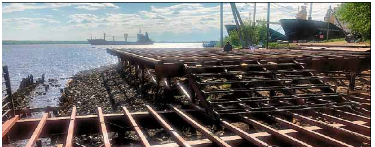
■ За Молодежным сквером создается новая набережная, которая обеспечит сквозной проход по всей прибрежной зоне города
