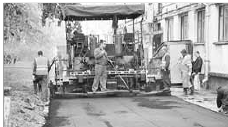
■ Начали ремонтироваться дворы – пожалуй, впервые со времен возведения домов
