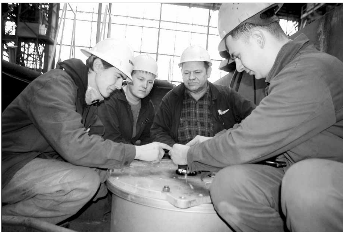
■ 2008 год. Слесари-монтажники бригады Александра Зверева (второй справа) выполняют срочную работу. Слева – Александр Спиридонов
