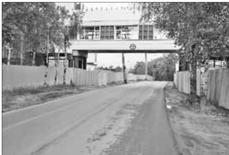
■ Ремонт проезда Сибирияковцев
