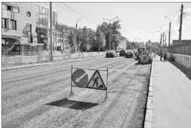
■ Набережная Северной Двины около МРВ
