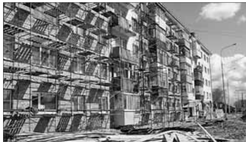
ФОТО: ФОНД КАПИТАЛЬНОГО РЕМОНТА АРХАНГЕЛЬСКОЙ ОБЛАСТИ
