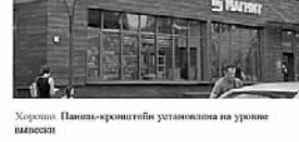
Хорошо. Панель-кронштейн установлена на уровне вывески.
