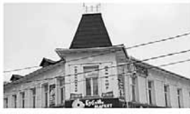
Плохо. Вывески ориентированы вертикально
