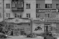
Плохо. Вывески размещены на уровне жилых этажей.
