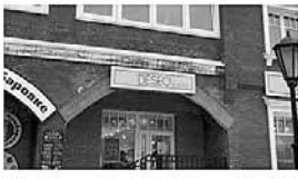
Плохо. Вывеска перекрывает архитектурные элементы фасада
