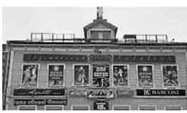
Плохо. Вывески занимают все пространство оконных проемов
