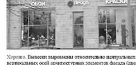
Хорошо. Вывески выровнены относительно центральных вертикальных осей архитектурных элементов фасада (дверей, окон).
