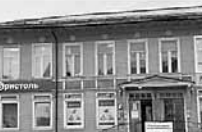
Плохо. Вывески выполнены без учета архитектурных особенностей фасада, перекрывающих архитектурные элементы здания.
