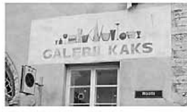
Плохо. Надпись и изображения нанесены непосредственно на поверхность фасада
