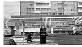
Плохо. На одном фасаде здания размещены две одинаковые вывески.
