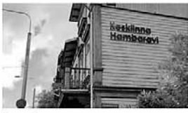
Хорошо. Фасад здания не повреждается информационными конструкциями
