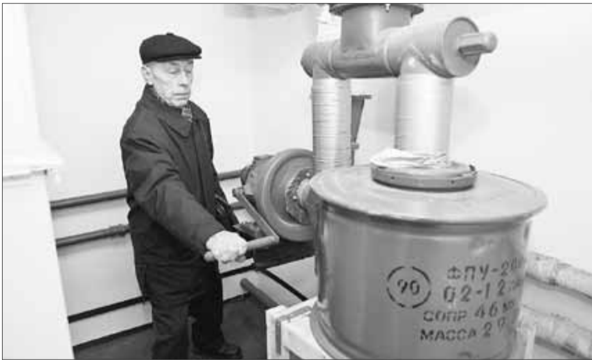
■ Фильтро-вентиляционная установка, обеспечивающая автономную подачу воздуха, может работать в ручном режиме. ФОТО: ИВАН МАЛЫГИН
