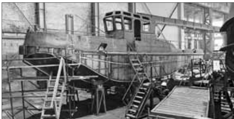
■ Строящийся рейдовый буксир – разработка конструкторского отдела «Красной Кузницы»
