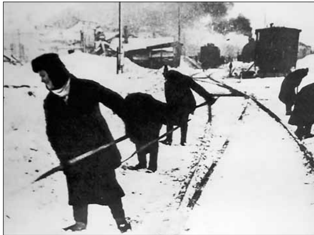
■ Работы по расчистке снежных заносов на железной дороге
