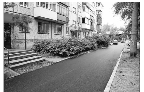
■ В 2021 году активно ремонтировались дворовые и межквартальные проезды
