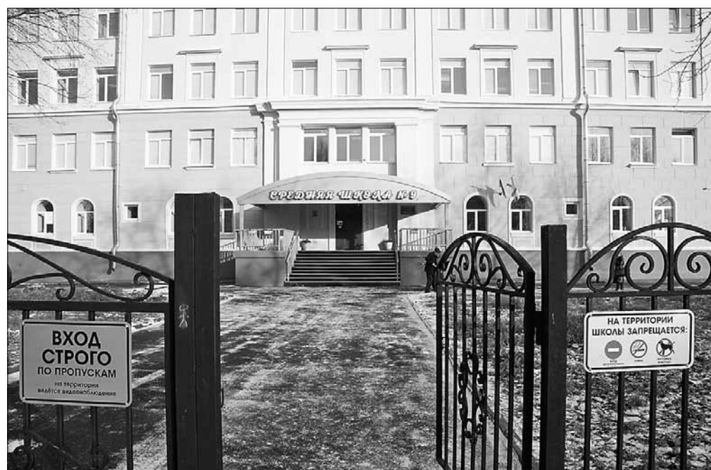
■ Проведен комплексный капитальный ремонт 9-й школы
