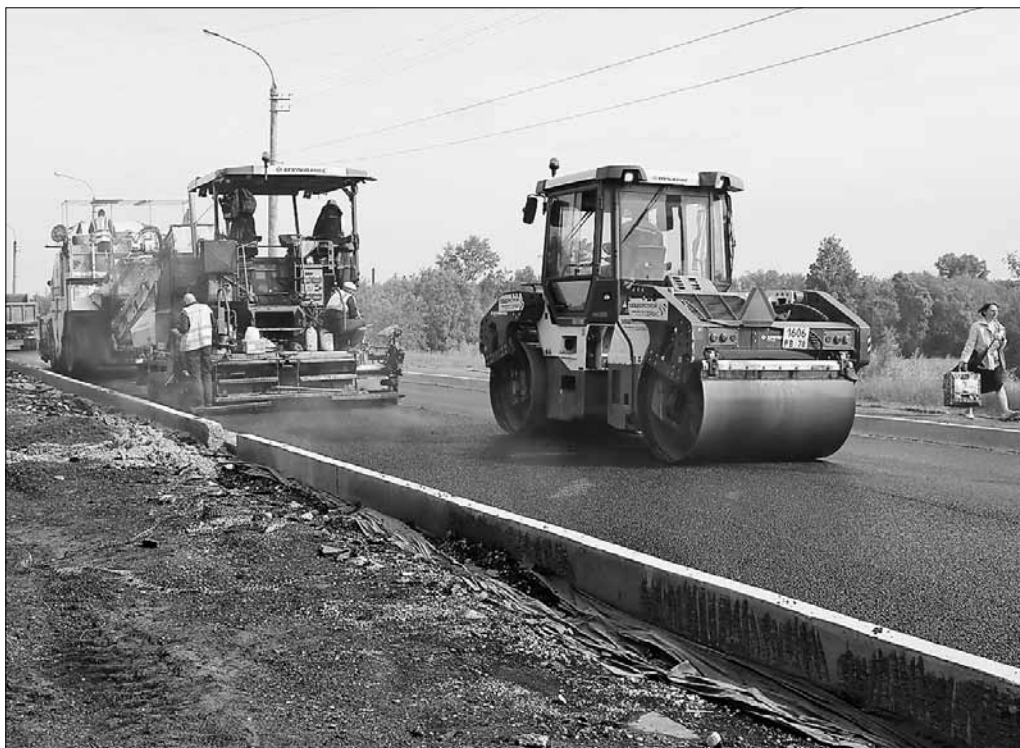
■ Ремонт улицы Победы
