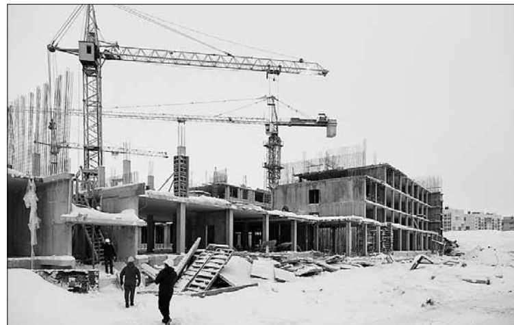
■ Ведется строительство школы на 1600 мест в округе Майская Горка
